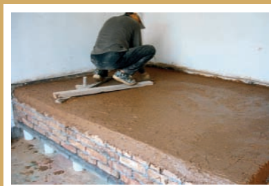
技工为吊炕抹泥
