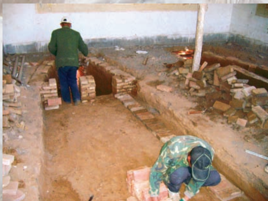
地热项目施工现场
